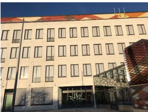
Julkisivu auringonsuoja efektit päällä
